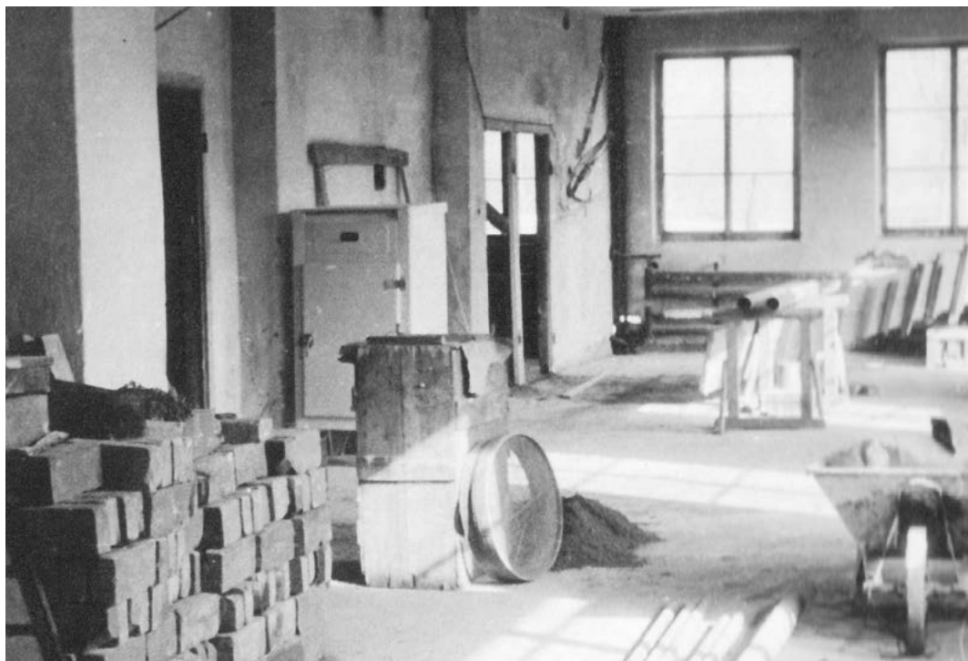
Die Baustelle des ersten Firmen- gebäudes 1948 (Bild oben) und die dort 1951 eingerichtete Lehr- werkstatt in Ingelfingen (Bild unten). Rechts im Hintergrund der langjährige Ausbildungsleiter Zimmermann.
