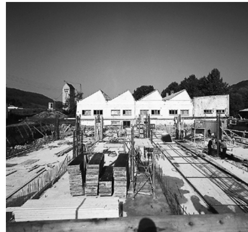
Bau der Shedhalle 3 in Ingelfingen 1970
