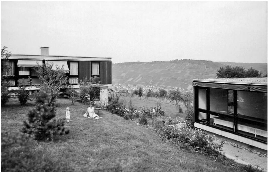
„Wettbewerb um die besten Köpfe“: der Bau von Mitarbeiterwohnungen ab 1949 in Ingelfingen
